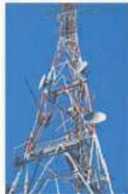
Uma modalidade de rádio enlace é o sistema em Visibilidade. Quando as frequências das ondas de rádio ultrapassam os 300Mhz, se propagam quase em linha reta, necessitando que as antenas transmissoras e receptoras fiquem uma de frente para outra. Relevos acentuados e distâncias elevadas podem inviabilizar o sistema.
